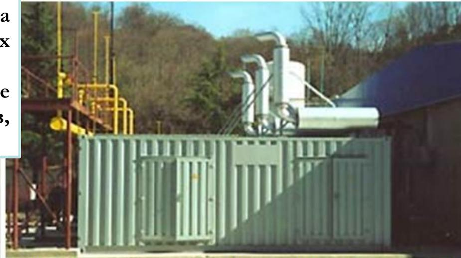
Компактная электростанция (мини - ТЭЦ) на базе поршневого двигателя, работающая на природном газе и вырабатывающая одновременно электроэнергию и тепло
